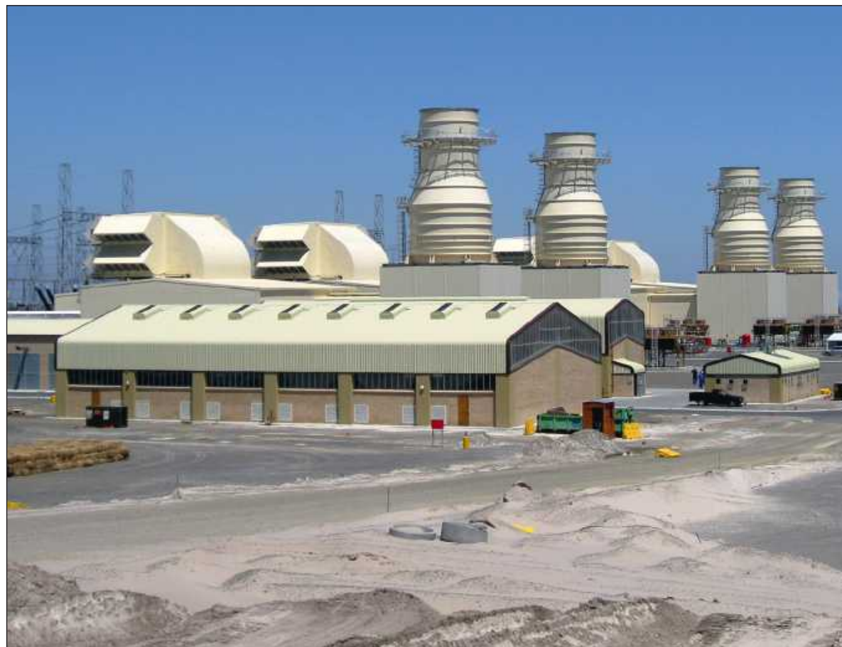
Gasturbinenwerk Atlantis bei Kapstadt in Südafrika: Dort ist INP für Inbetriebnahme und Montage zuständig. FOTO: INP
