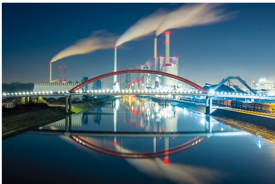
Bild 1. Grosskraftwerk Mannheim, Foto: Dirk Schatz / www.photo-schatz.de .
